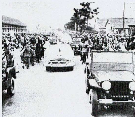
Escorté par les indigènes, le cortège royal gagne, par la route de terre rouge, la centrale et le barrage Delcommune, dont il visitera toutes les installations.
