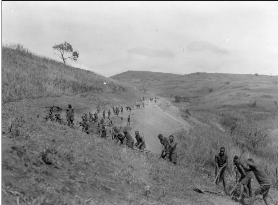
LA CONSTRUCTION D'UNE ROUTE
