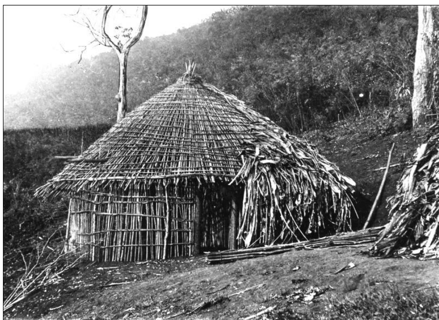
UNE MAISON EN CONSTRUCTION
