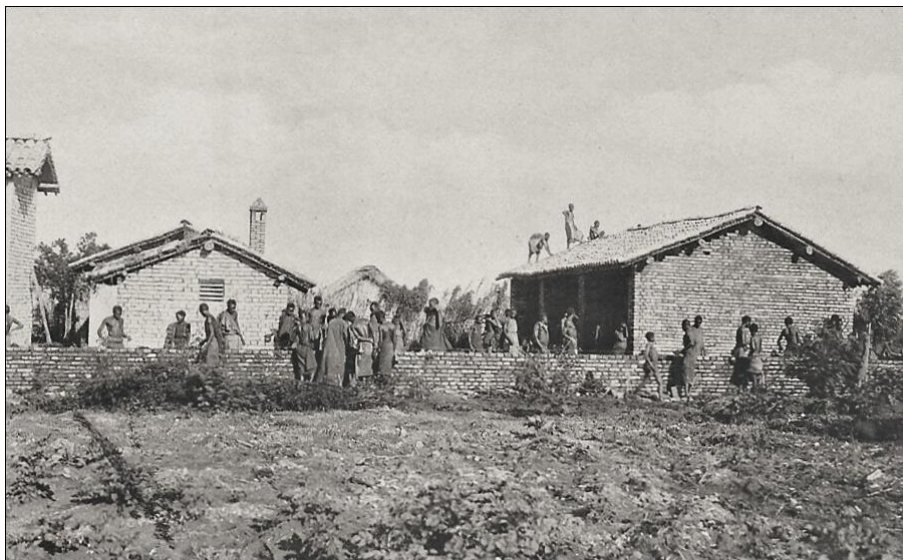
DEBUTS DE LA CONSTRUCTION DE HUYE (ASTRIDA - BUTARE)
