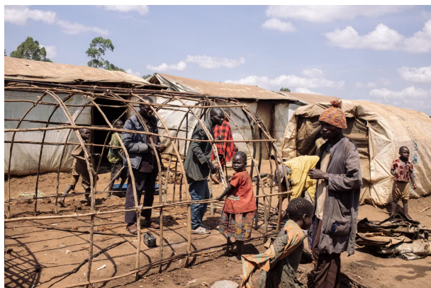
Construction d'un abri dans le camp de déplacés de Plaine Savo, en République démocratique du Congo, le 13 juin 2026. Philémon Barbier/hors format pour « Le Monde »
